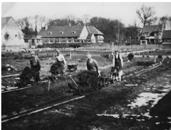
De eerste fase: afgraven van het maaiveld. Foto: pastoor Meijnsing
