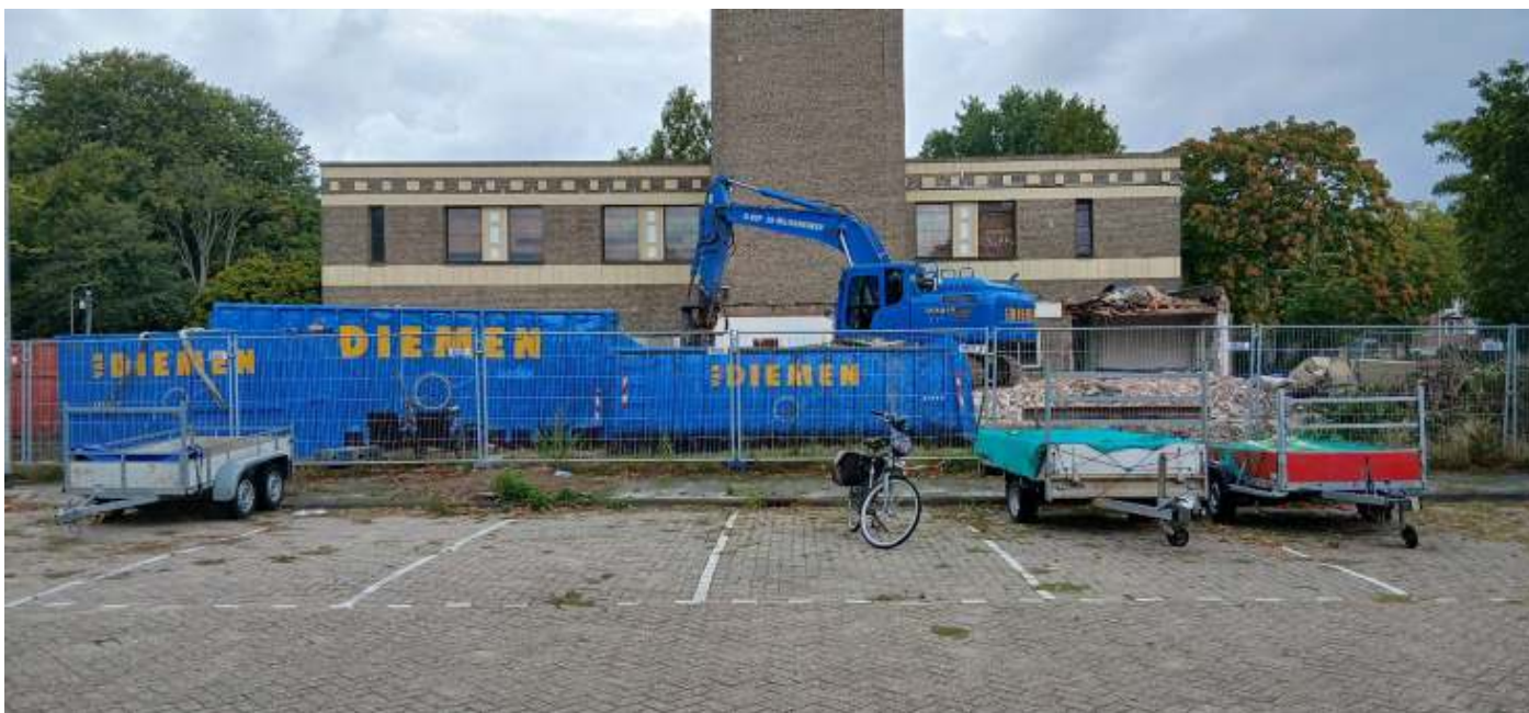
De door Van Diemen Sloopwerken gesloopte voormalige pastorie en parochiezaal Sion en het dak van de kerkzaal, gezien vanaf de Ter Weerlaan. Foto: Tomek Sloekers
