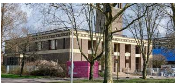
Maart 2026: de stalen constructie van het dak gezien vanaf de kruising Burmanlaan-Parklaan..Foto: Tomek Sloekers
