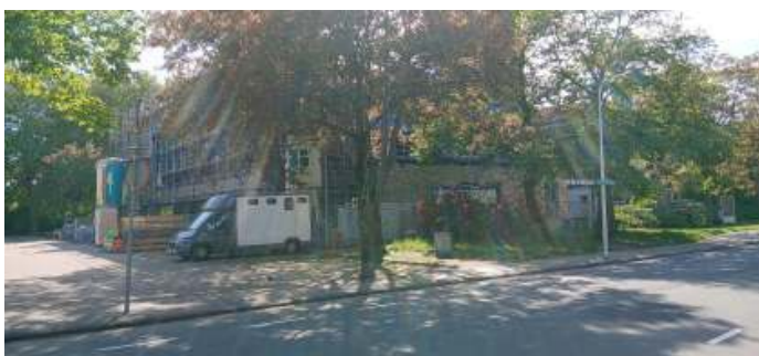
Mei 2026: Het nieuwe metselwerk van het nieuwbouwgedeelte gezien vanaf de kruising van de Van Cranenburglaan - Ter Weerlaan.
